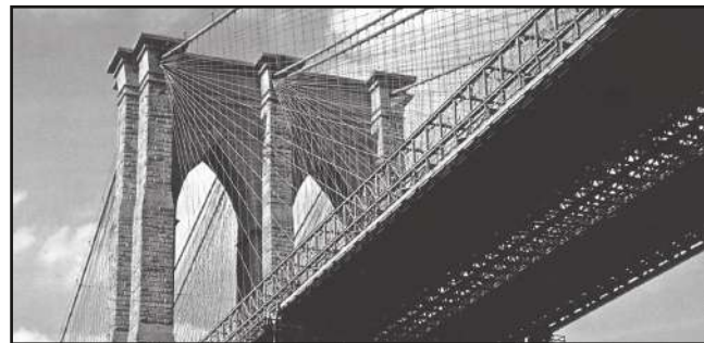
Il Ponte di Brooklyn a New York con i suoi cavi metallici in un disegno dell'epoca (1870)
